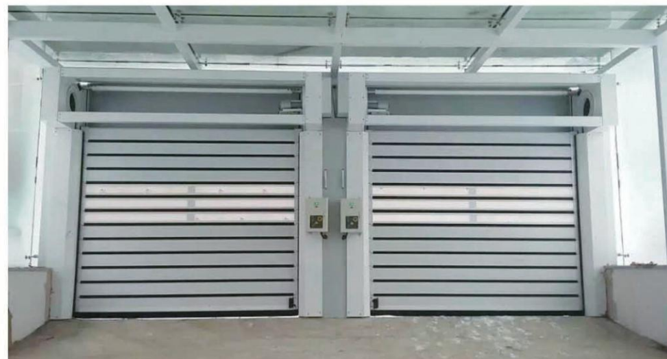
硬质快卷门（地下车库） Hard fast rolling door (underground garage)
