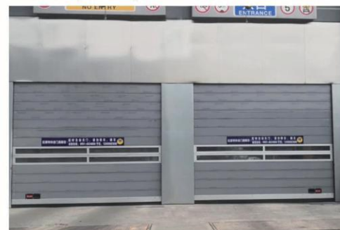
硬质快卷门（地下车库） Hard fast rolling door (underground garage)
